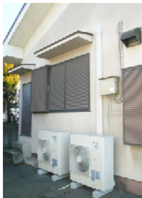
新しくなった会館の空調設備！
